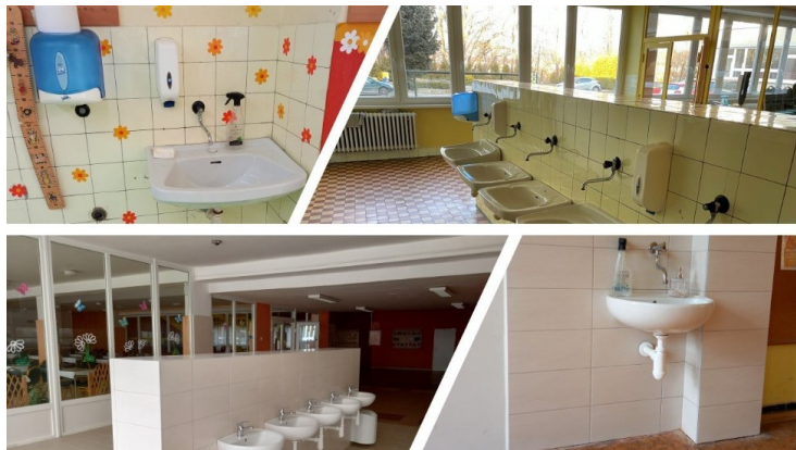
Rekonštrukčné práce v škole 2022
